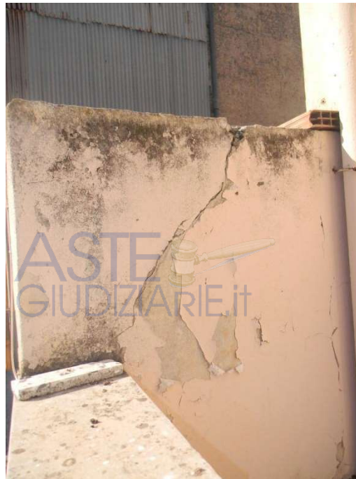
Foto 27: particolare dei muretti in corrispondenza del terrazzino al secondo piano
