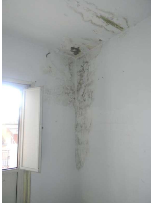
Foto 21: vano su via Cavour al secondo piano
