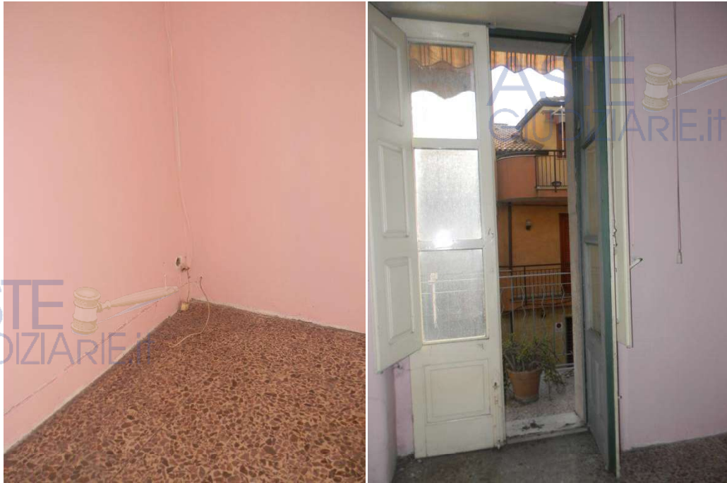
Foto 16: a sinistra particolare dell'impianto elettrico; a destra particolare dell'infisso
