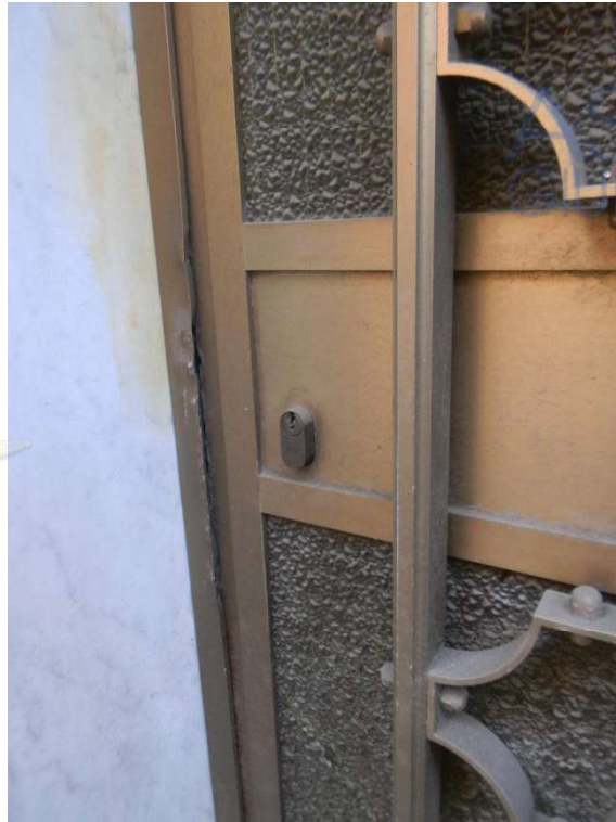
Foto 1: porta d'ingresso prima dell'intervento
