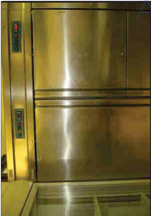
Foto n°29 - Torre dei Corsari
