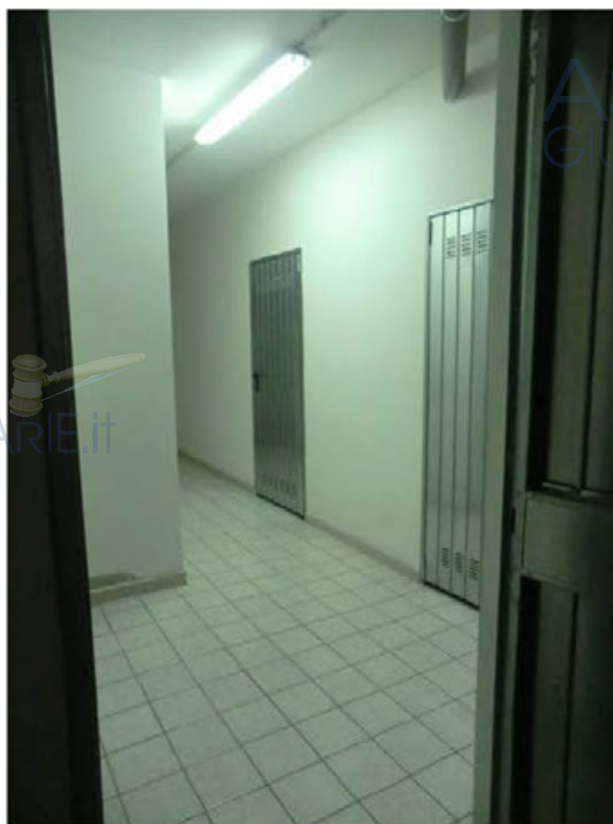
Foto n.7.Via Antonio Stradivari n.1. Disimpegno cantine.
