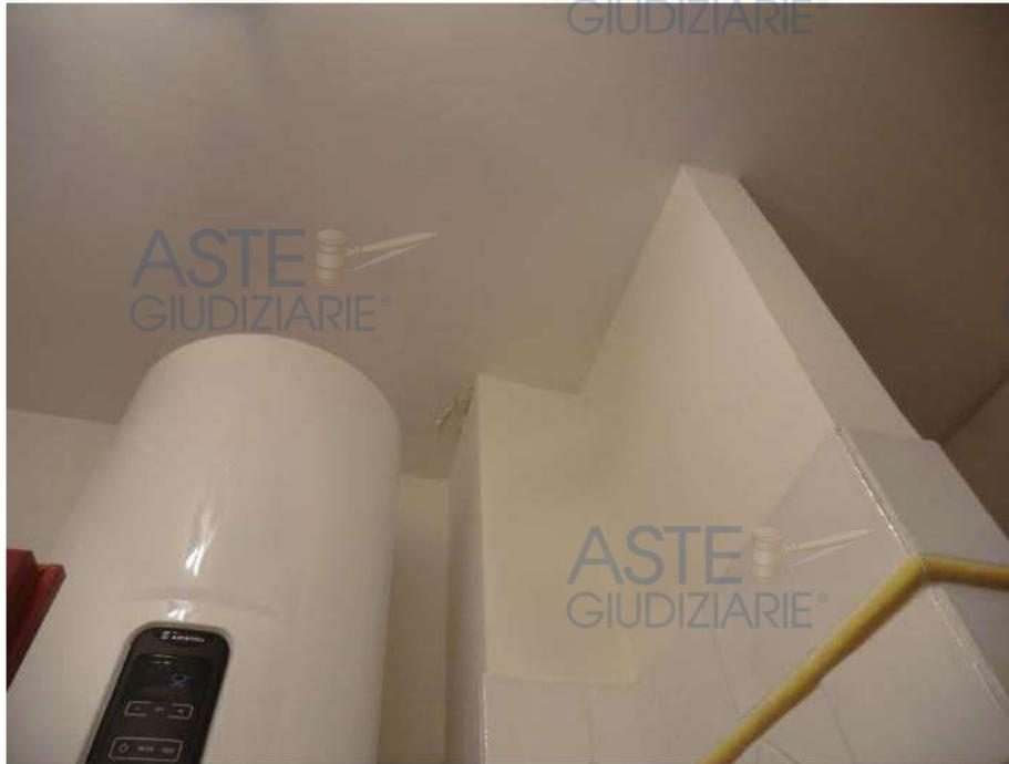
Foto n.12 . Via Parigi n.5F- Villasimius. Bagno principale. Tracce di infiltrazioni in corrispondenza di un finto pilastro sede della colonna montante degli scarichi delle acque nere.
