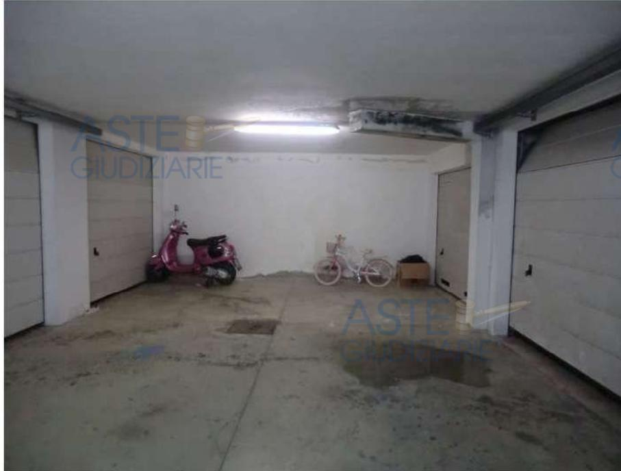
Foto n.26 .Via Parigi n.5E- Villasimius. Box auto. Sono visibili le copiose infiltrazioni provenienti dall'immobile sovrastante e le tracce di acqua sul pavimento.
