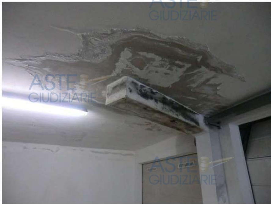
Foto n.27 .Via Parigi n.5E- Villasimius. Box auto. Sono visibili le copiose infiltrazioni.
