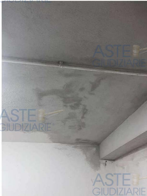
Foto n.29 .Via Parigi n.5E- Villasimius. Box auto. Sono visibili le infiltrazioni dopo i recenti
