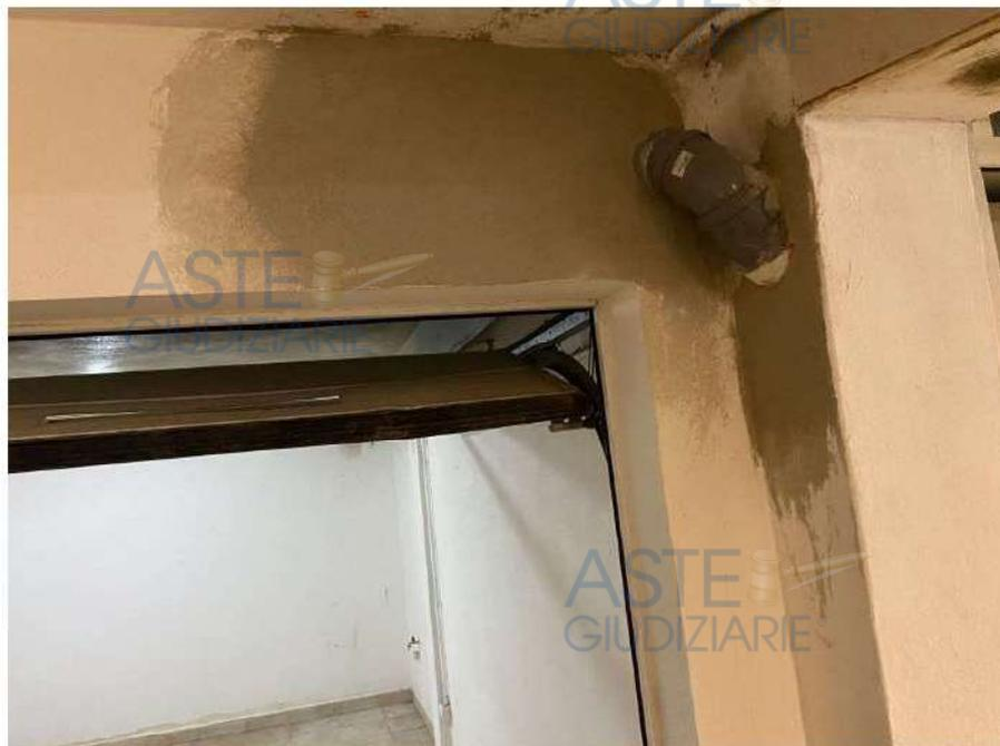
Foto n.30 .Via Parigi n.5E- Villasimius. Box auto. E' visibile la curva di collegamento con la colonna montante di scarico delle unità immobiliari sovrastanti.
