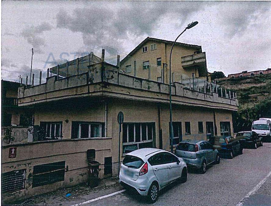
Presenta una struttura in c.a. con fondazioni a plinti collegati fra loro mediante travi rovesce. I solai sono del tipo misto con travetti in c.a.p.. Le murature di tamponamento sono state realizzate con doppio tavellato di laterizi forati dello spessore di cm12 all'esterno e cm.8 all'interno.
