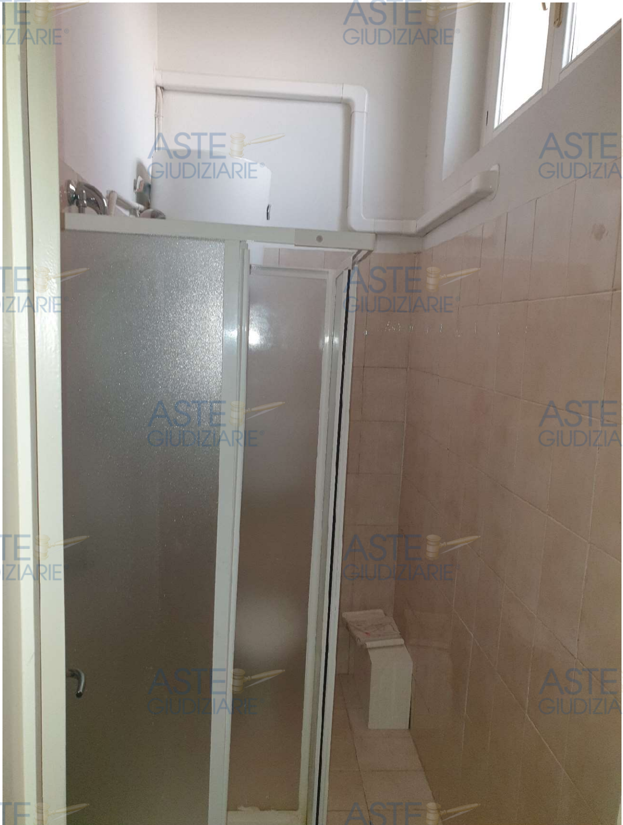
Fotografia 4. Vista interna del bagno che a prima vista sembrerebbe in ordine. Si precisa che lo scrivente non ha effettuato nessuna prova idraulica o elettrica di verifica e conformità degli impianti.
