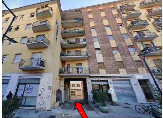
Vista dell'ingresso al corsello da via Corsica n° 169
