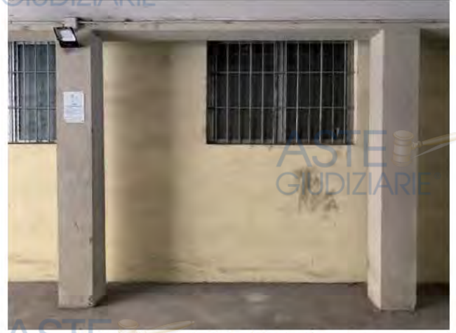
Parte del prospetto visto dal corsello comune
