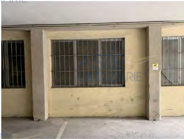
Parte del prospetto visto dal corsello comune
