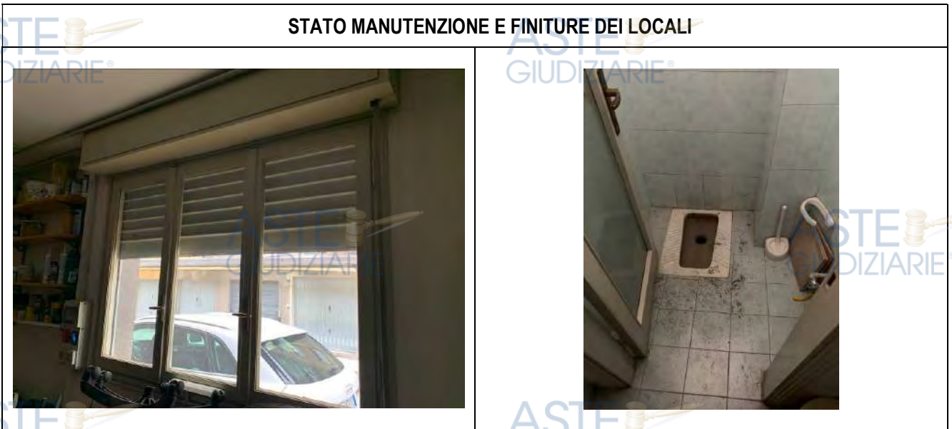
Figura 2.8: Stato manutenzioni e finiture magazzino
