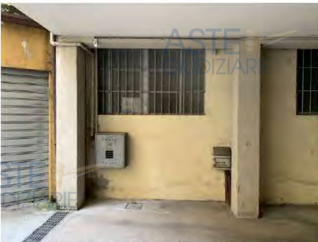
Parte del prospetto visto dal corsello comune
