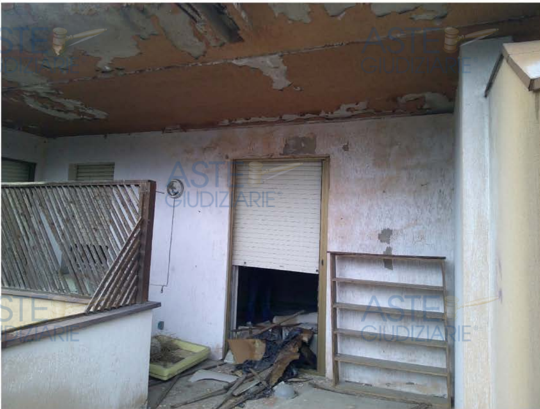
FOTO 10 BALCONE CON EVIDENTI PROBLEMI DI UMIDITA'
