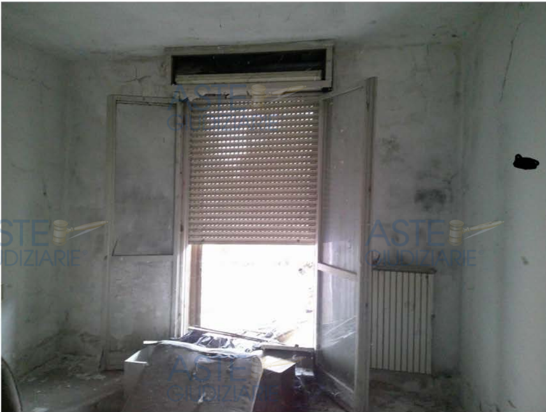
FOTO 10 BALCONE CON EVIDENTI PROBLEMI DI UMIDITA'
