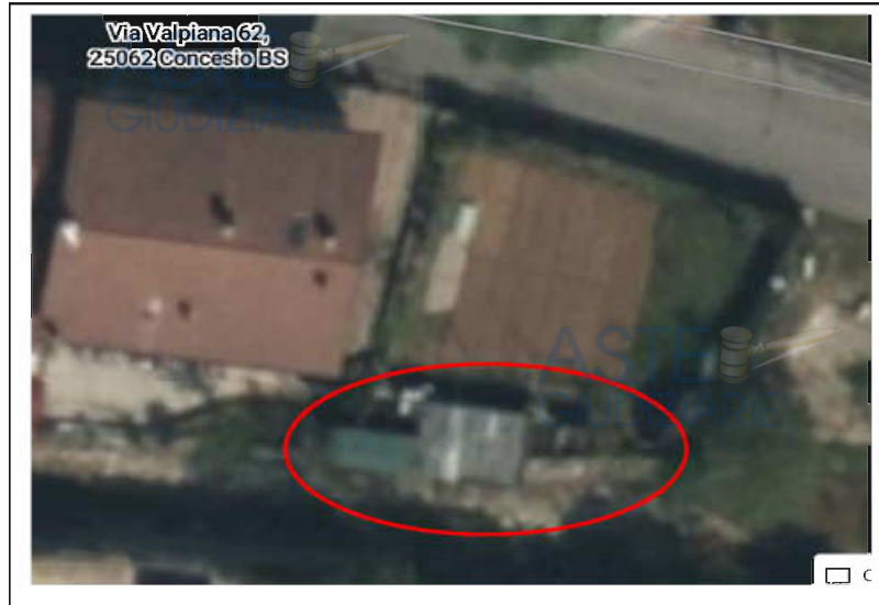
Fotografia aerea riprendente le costruzioni accessorie abusive tratta da Google maps
