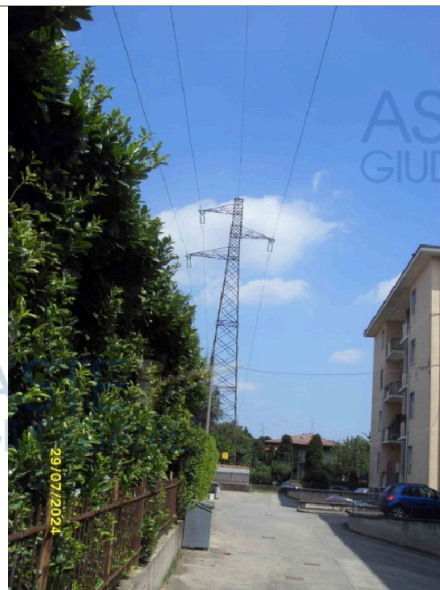
Elettrodotto presente su area condominiale
