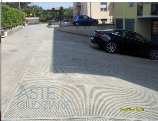
Corsello condominiale accesso autorimessa
