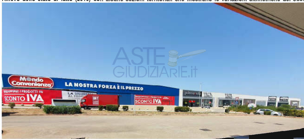
Foto n.1: Vista del Corpo C2 del lotto C in cui sono visibili gli ingressi e le insegne delle attività commerciali ivi operanti
