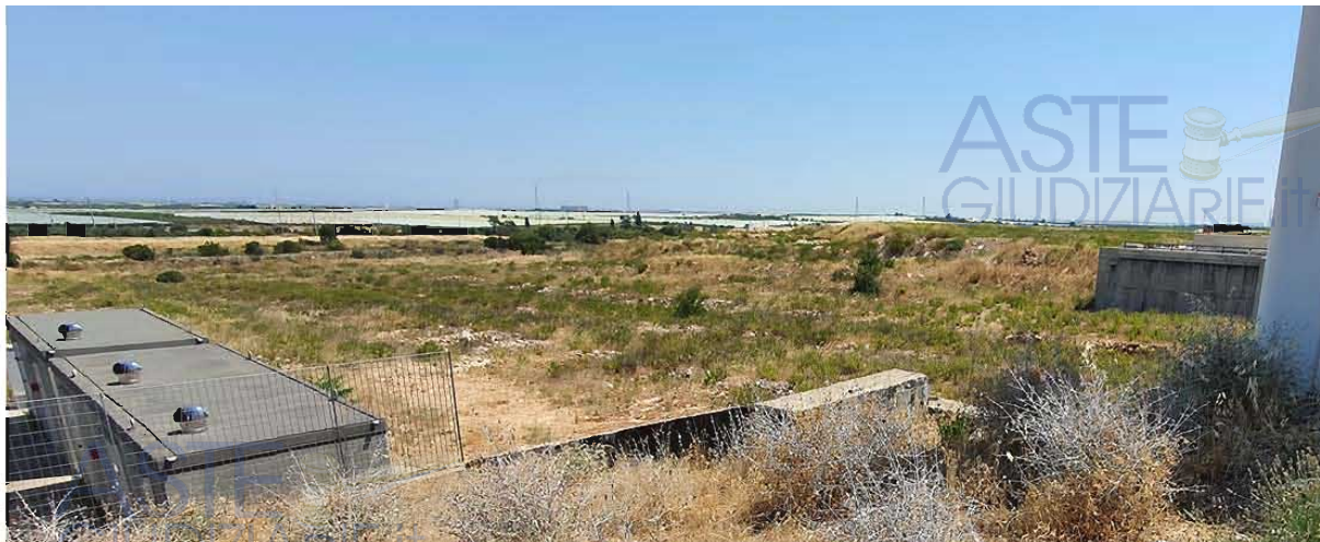
Foto n.6: Vista, da sud-ovest verso nord-est, delle aree inedificate del lotto in stima, dal punto in cui sono posizionate le tre cabine elettriche, in corrispondenza della testata del corpo C2,
