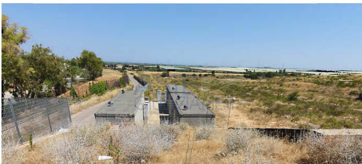
Foto n.5: Vista da sud verso nord delle aree inedificate del lotto in stima, dal punto in cui sono posizionate le tre cabine elettriche, in corrispondenza della testata del corpo C2,
