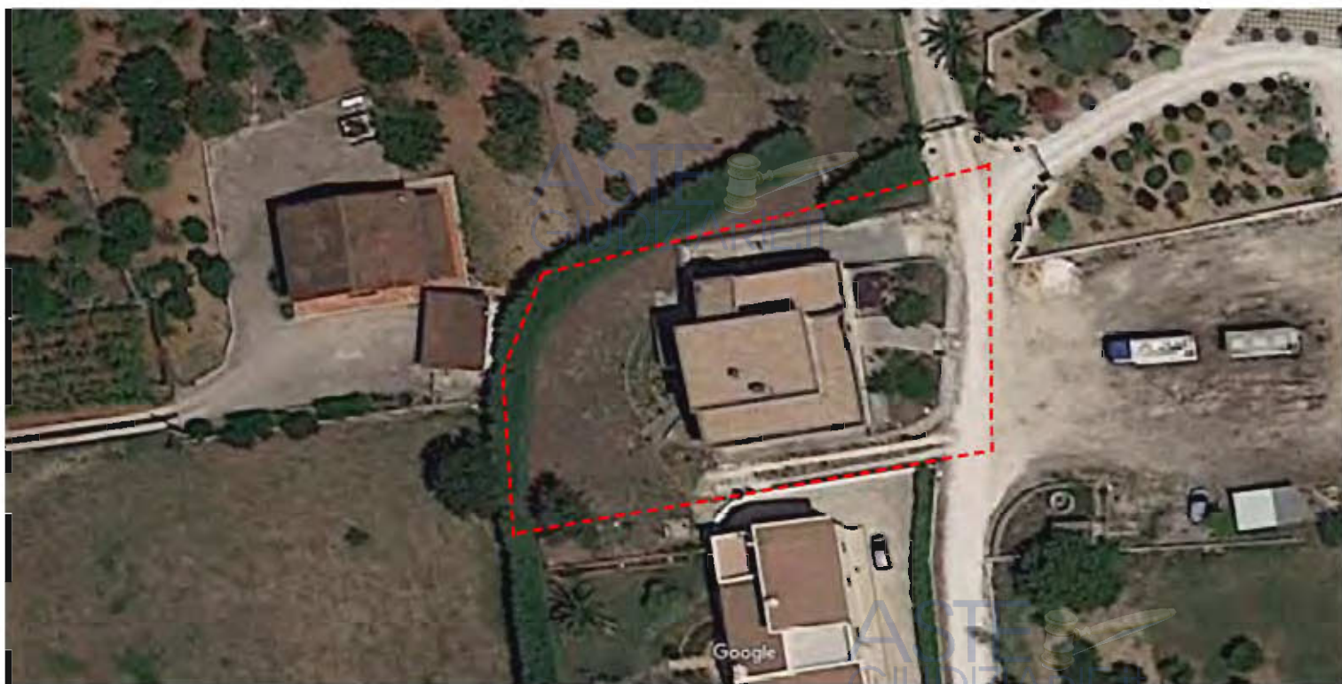
Vista dall'alto del fabbricato allo stato rustico con terreno circostante
