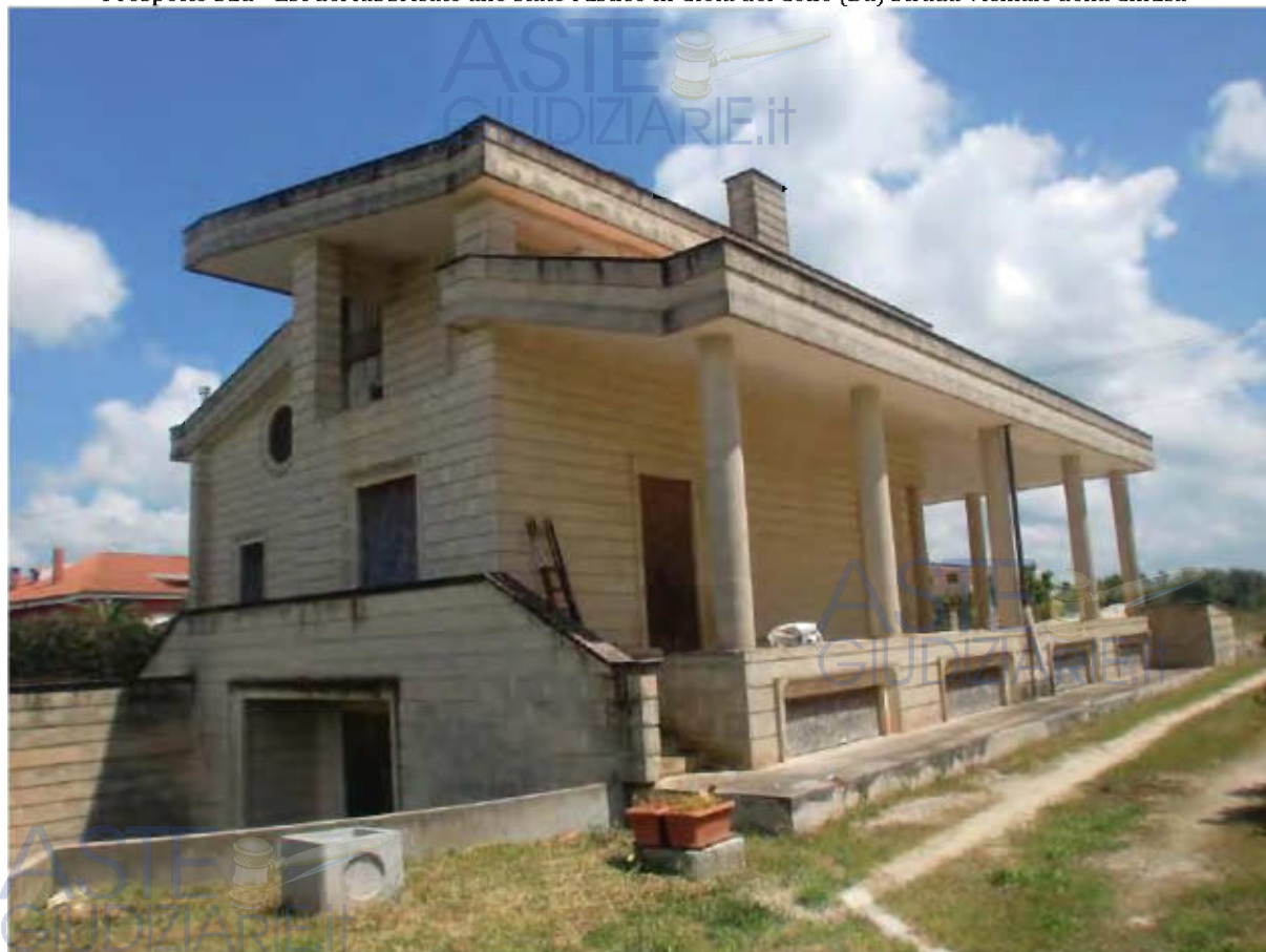
Prospecto Sud - Ovest del fabbricato allo stato rustico in Gioia del Colle (Ba) Strada Vicinale della Chiusa
