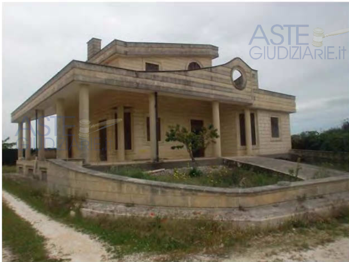
Prospecto Sud - Est del fabbricato allo stato rustico in Gioia del Colle (Ba) Strada Vicinale della Chiusa
