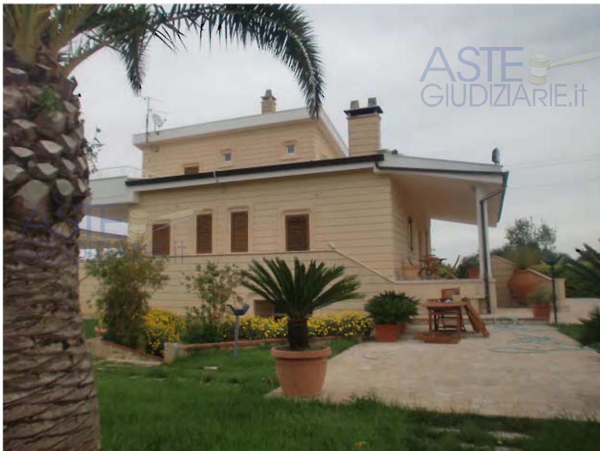
Prospetto Sud Ovest della villa in Gioia del Colle (Ba) Strada Vicinale della Chiusa, 1781/A
