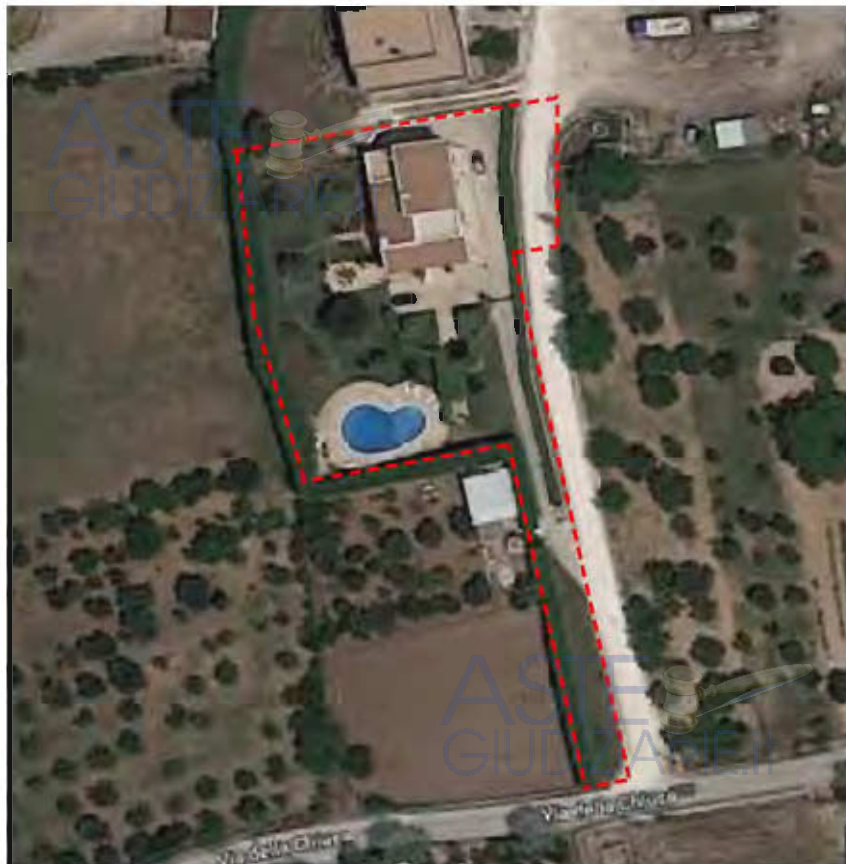
Vista dall'alto della villa con giardino pertinenziale in Goia del Colle (Ba) Strada Vicinale della Chiusa n. 1781/A
