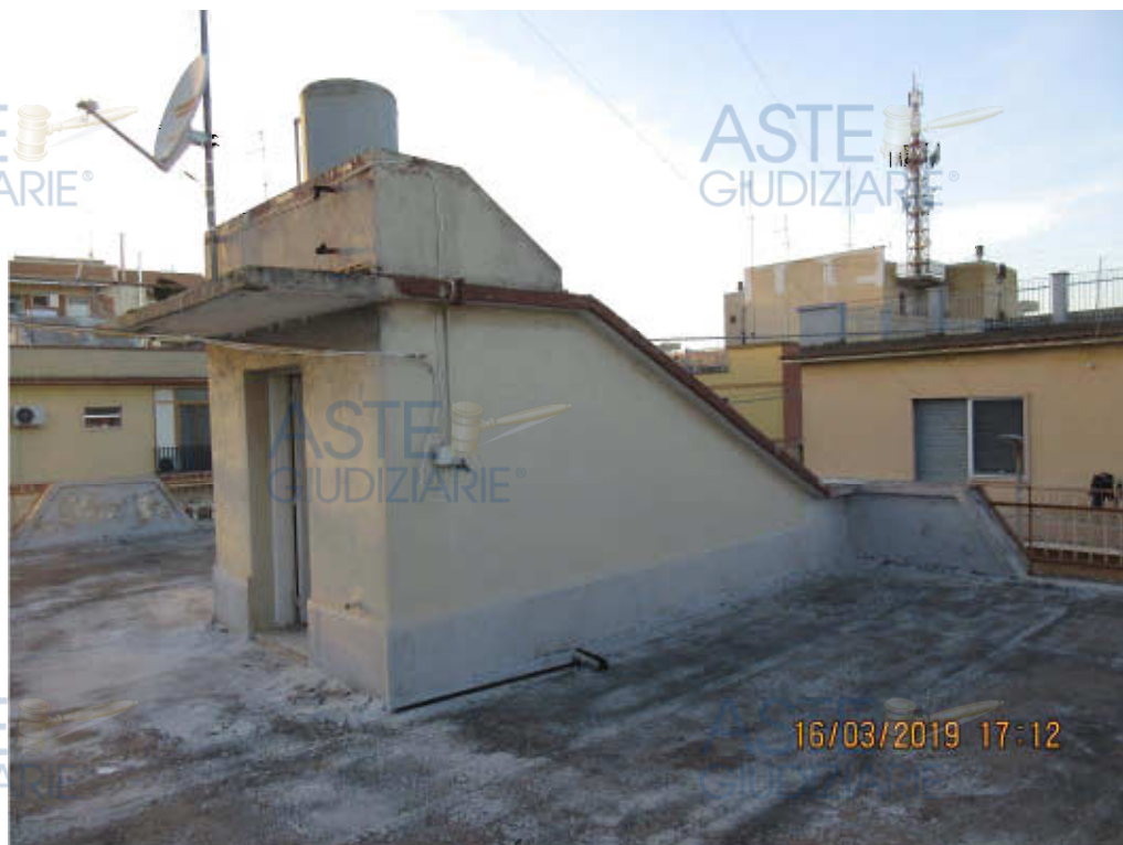
Foto n.39 Torrino del vano scale al livello del lastrico solare
