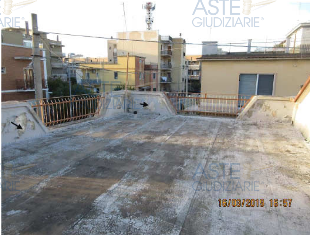
Foto n. 36 Precarie condizioni del lastrico solare e dei parapetti
