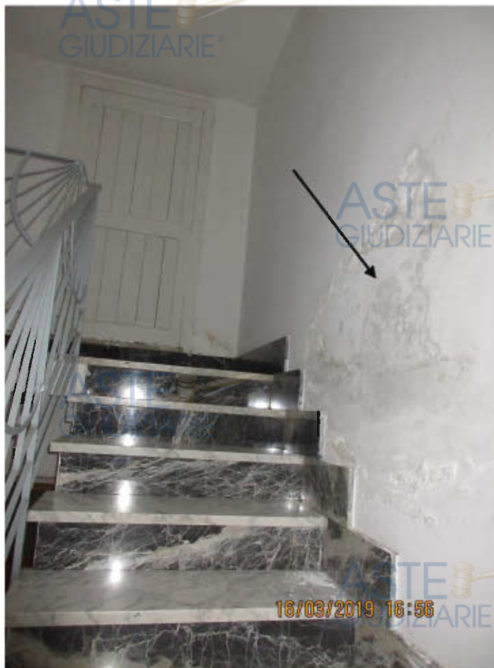
Foto n. 34 Vano scale in corrispondenza del terrazzo con fenomeni infiltrativi
