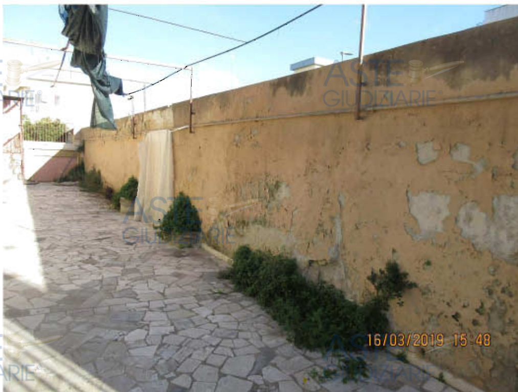
Foto n.5 Cortile interno con degrado della parete di confine con l'altra proprietà.
