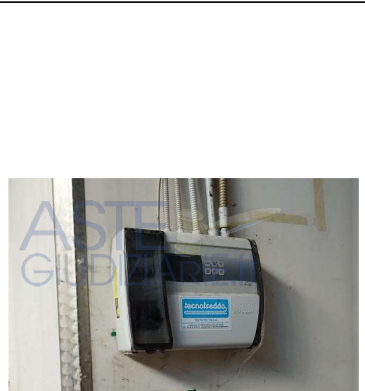
Foto 111- Comando elettrico frigo
