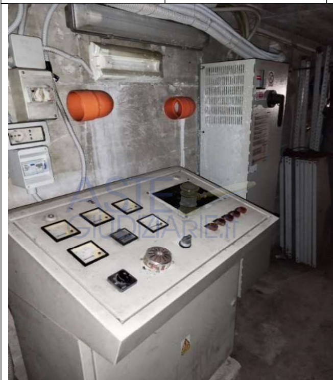
Foto 89- Quadro elettrico Gruppo elettrogeno da 45 kW
