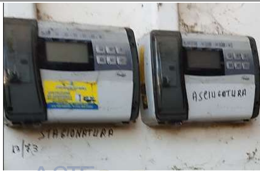
Foto 110- Comando elettrico frigo
