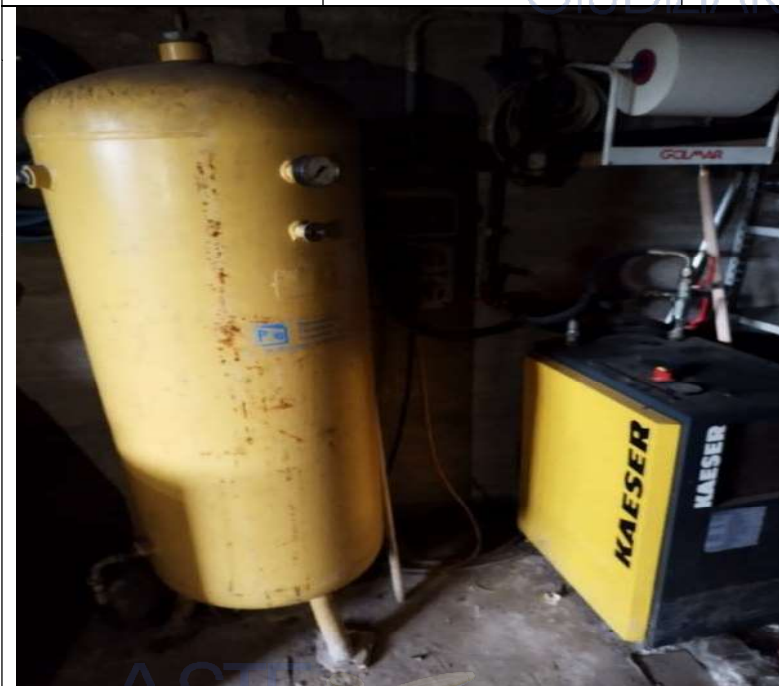
Foto 90- Compressore con quadro comando, serbatoio ed essiccatore
