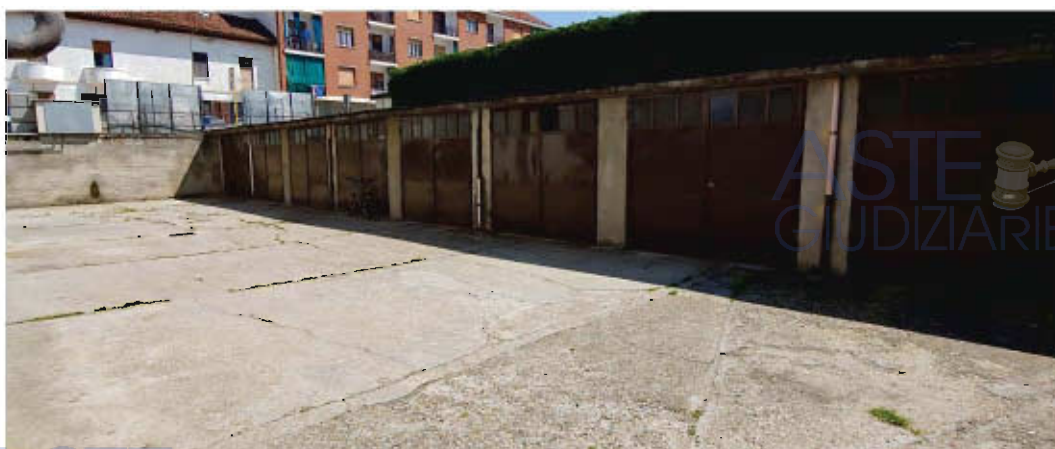
Vista cortile – autorimesse blocco indipendente
