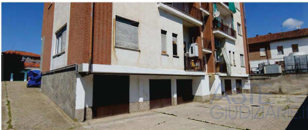
Vista cortile – autorimesse al piano seminterrato
