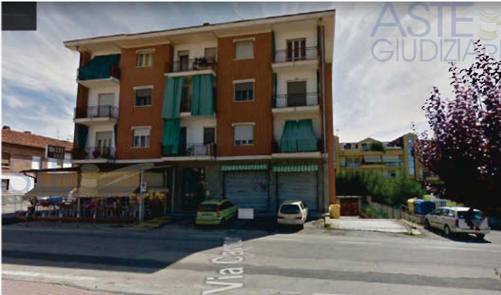
Vista prospetto su via cavour (a destra la rampa di accesso al cortile)
