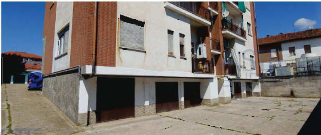
Vista cortile – autorimesse al piano seminterrato
