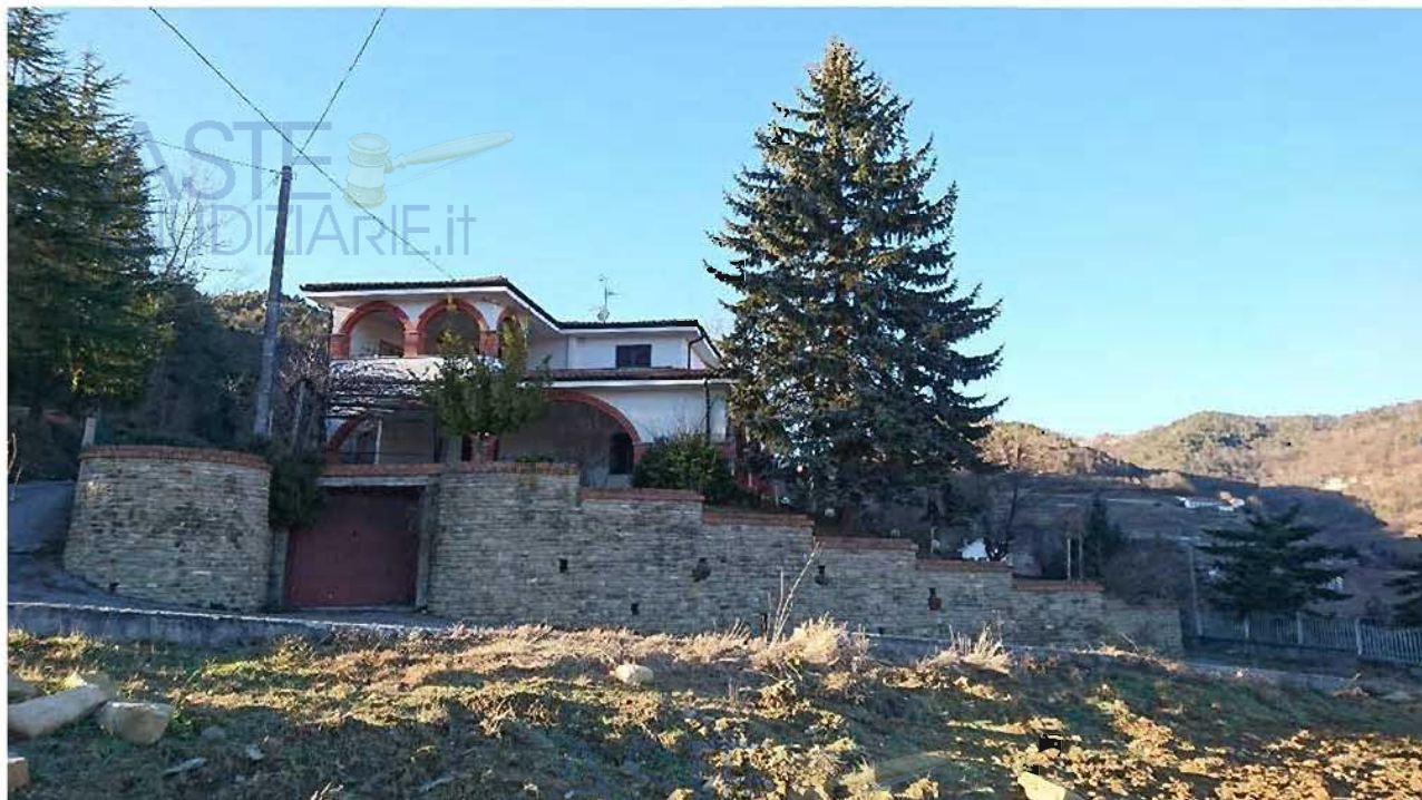
Fig. 8 - vista del fabbricato e dell'accesso all'autorimessa - fronte sud
