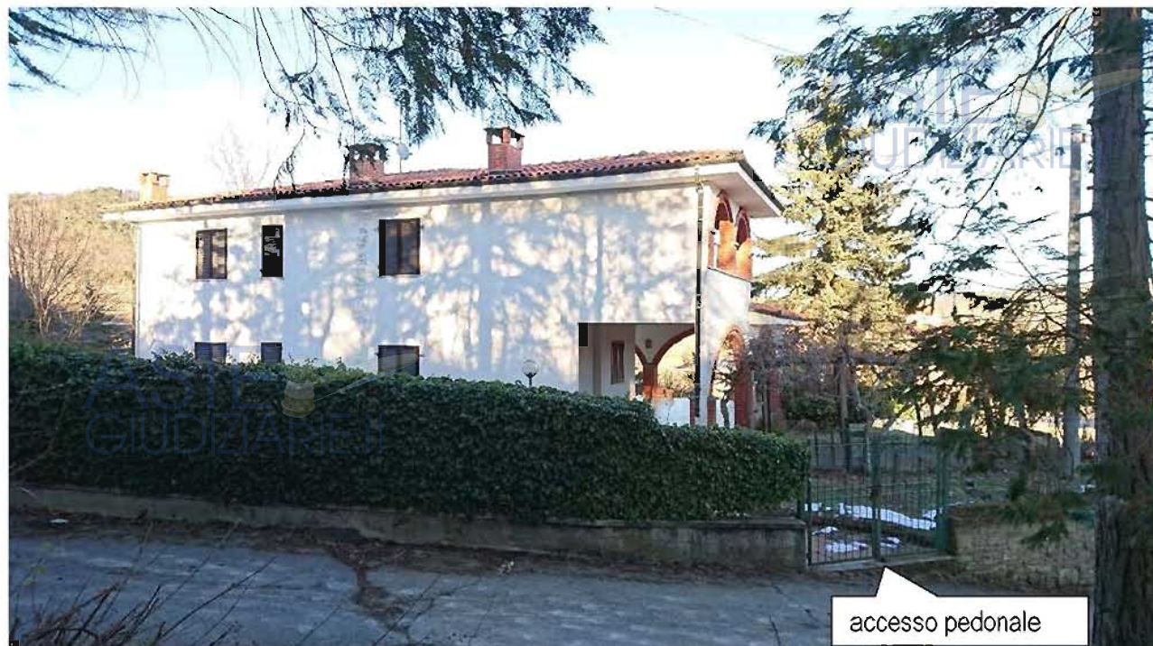
Fig. 7 - vista degli immobili dalla strada comunale "sentiero della nocciola" – fronte ovest
