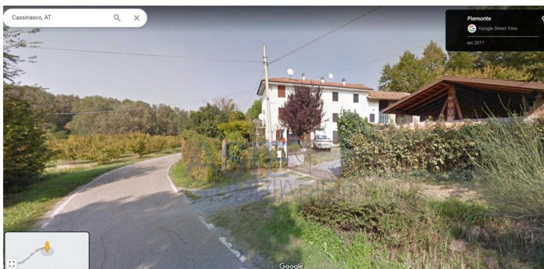
Foto 2: Vista Google Maps del fabbricato
