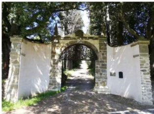
Ingresso alla villa (p.209)
