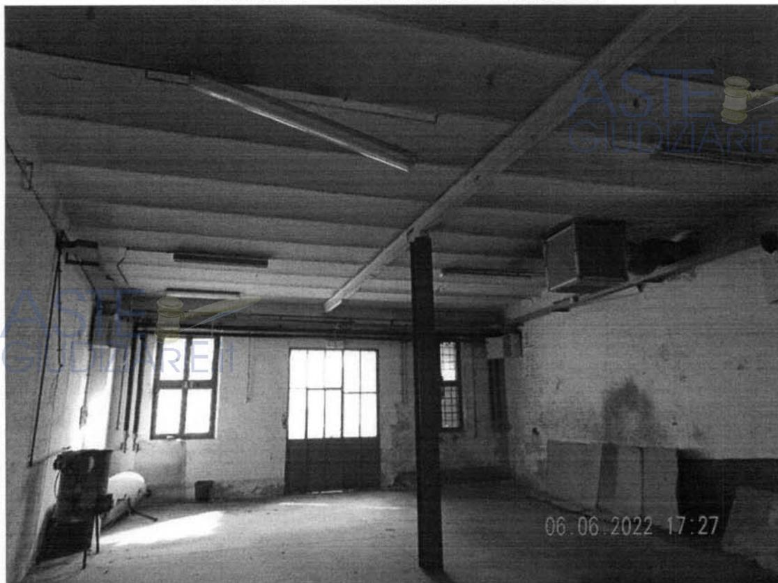
Foto 4 – Parte della P/lla 213 con solaio calpestabile ed accesso alla P/lla 481 (Ente urbano). Si evidenzia la puntellatura provvisoria.
