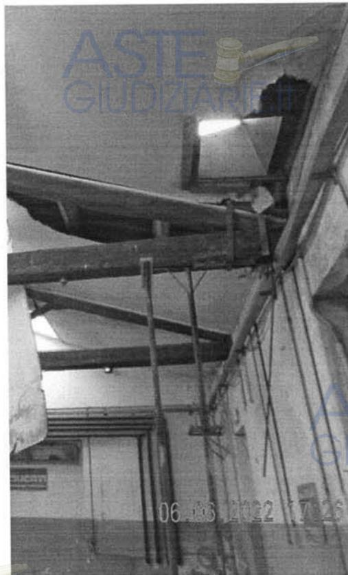
Foto 11 – Particolare che evidenzia il cedimento di un capriata di una parte della P/lla 193 Sub I con puntelli provvisori.
