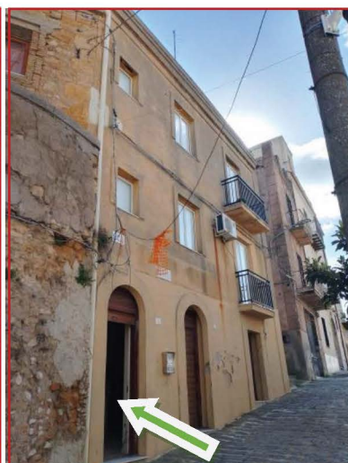
Vista da via San Giuliano accesso
