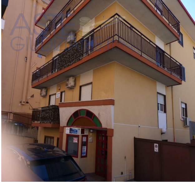
Foto n° 1 Portone accesso immobile
