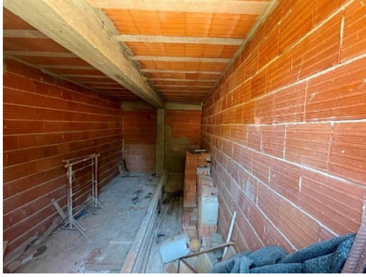
Locali al P.T. (Edificio 1)
