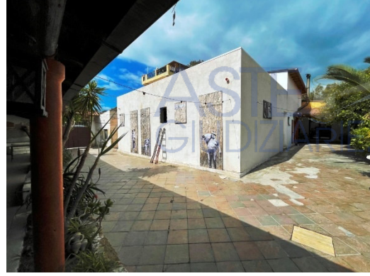
Locali al grezzo, pertinenza
