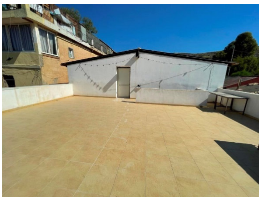
Terrazza e locale al P.1° (Edificio 1)
