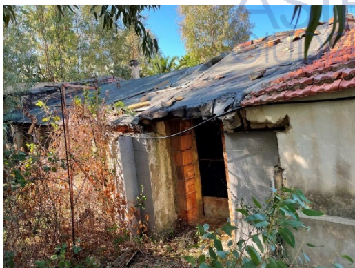
Edificio 3 (Vista da Est)
