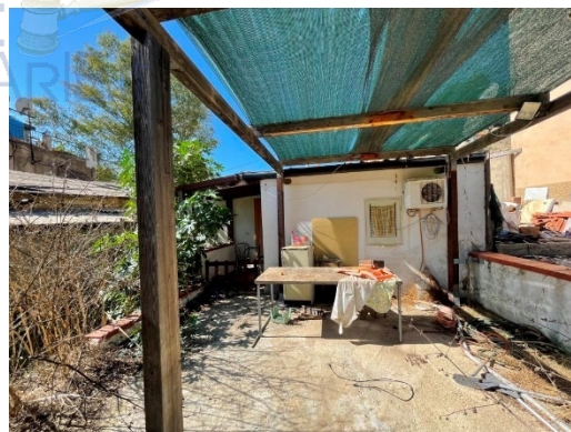
Edificio 4 (Vista da Est)
