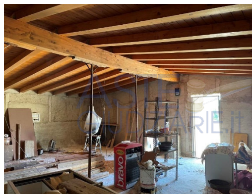
Locale al P.1° (Edificio 1)
