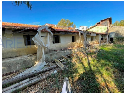
Edificio 3 (Vista da Sud-Est)
