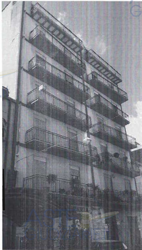
Prospetto principale dell'immobile condominiale su Corso della Repubblica (esposto a nord)
