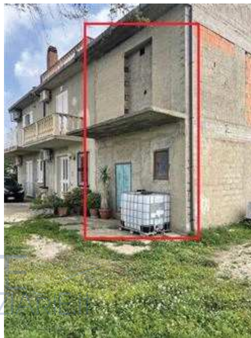
IMMOBILE ALLO STATO ALLO STATO GREZZO PROSPETTO SULLA STRADA PROVINCIALE
