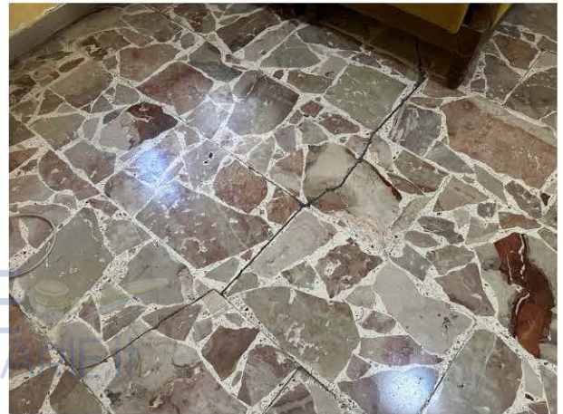
Lesione pavimento piano primo
