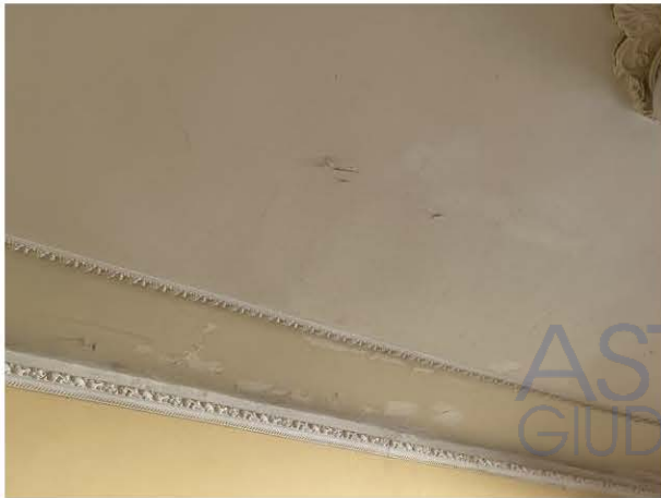
Infiltrazioni piano primo
