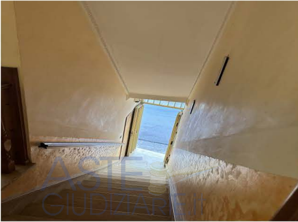
Scala di accesso al piano primo
