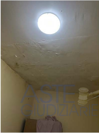
Infiltrazioni camere piano terra
