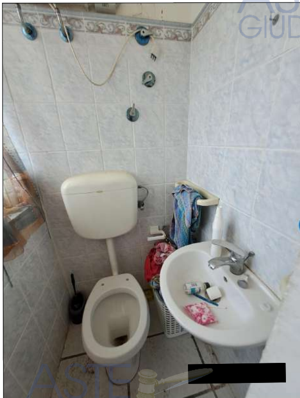
piano terzo - bagno
