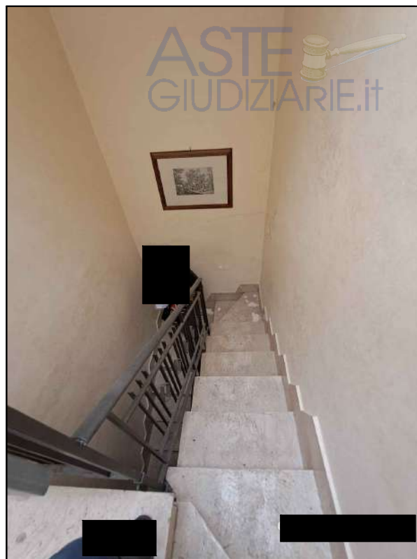
piano terzo - scala di accesso
