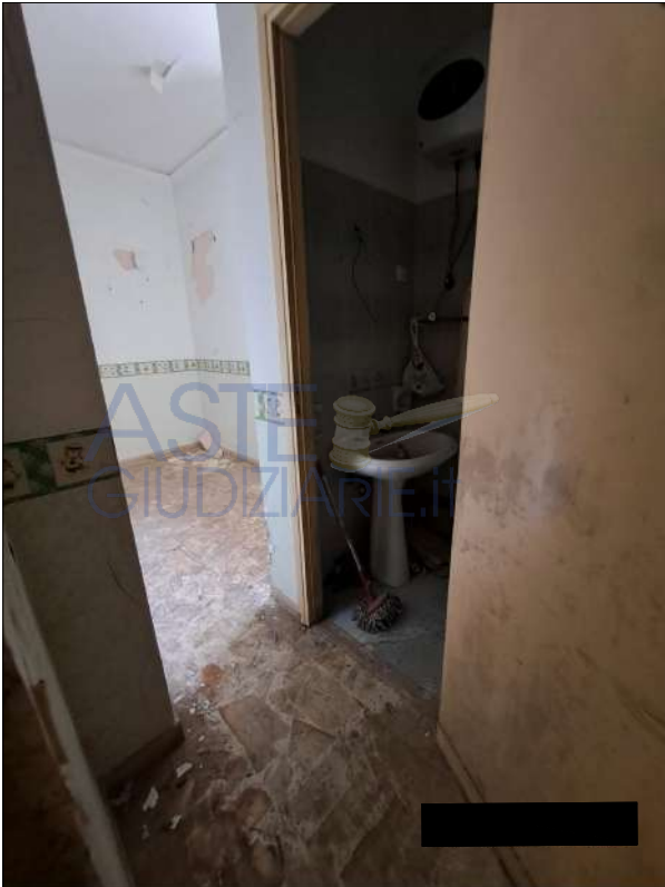
piano primo - disimpegno
