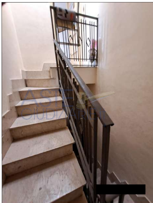
piano terzo - scala di accesso
