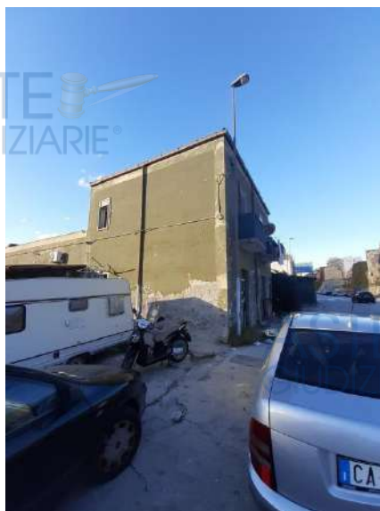
Foto 2 – Fabbricato Via Marina Ponente, 67
