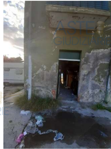
Foto 19 - Piano terra: «Deposito»
