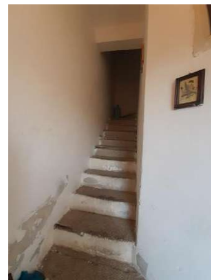
Foto 4 – Vano scala per accesso ad appartamento 1° piano
