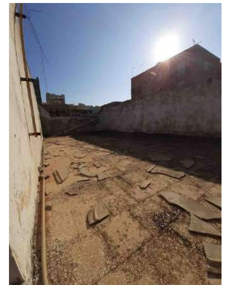
Foto 34 – Lastrico solare 2° Livello
