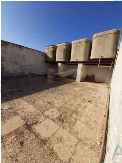
Foto 35 – Lastrico solare 2° Livello
