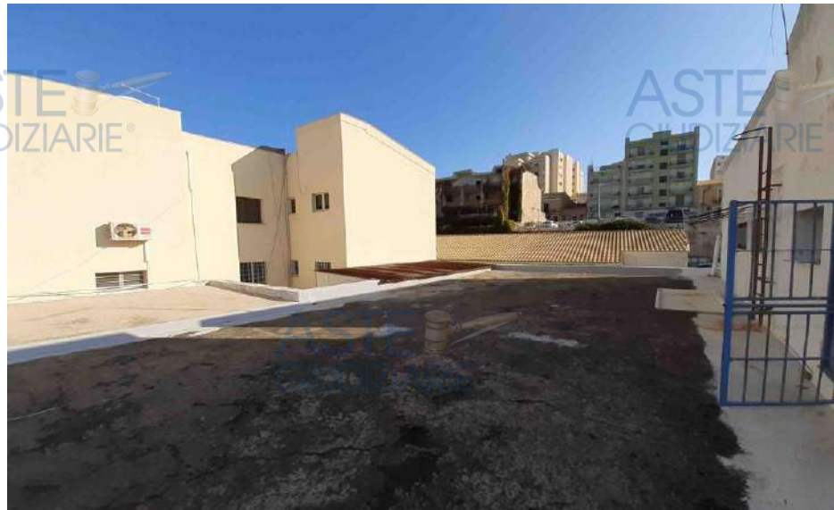
Foto 33 – Lastrico solare 1° Livello
