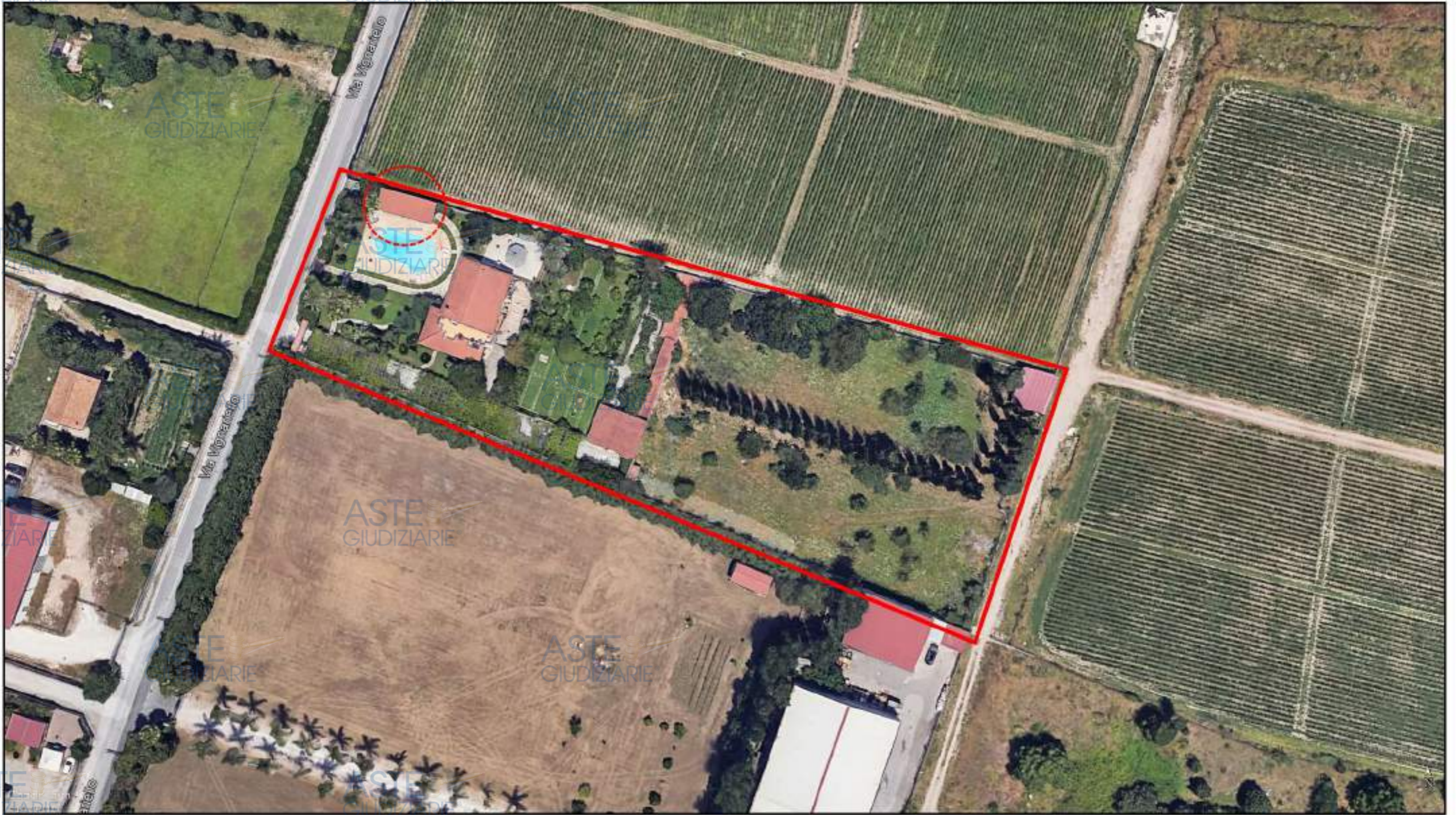
Ortofoto dei luoghi (in evidenza il compendio immobiliare pignorato e l'ubicazione dell'unità immobiliare in oggetto)
