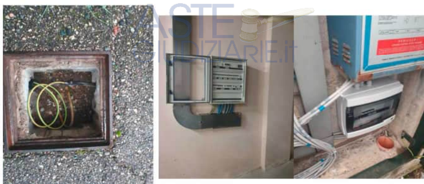
Foto 5 - Posa Massa a terra e nuovo contatore
