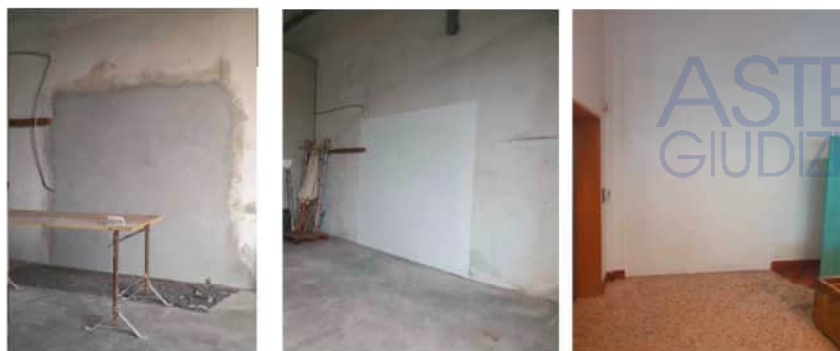
Foto 3 - Porta comunicante - Chiusura con tamponamento e tinteggiatura finale
