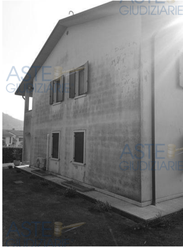
dettaglio del prospetto nord del bene pignorato
