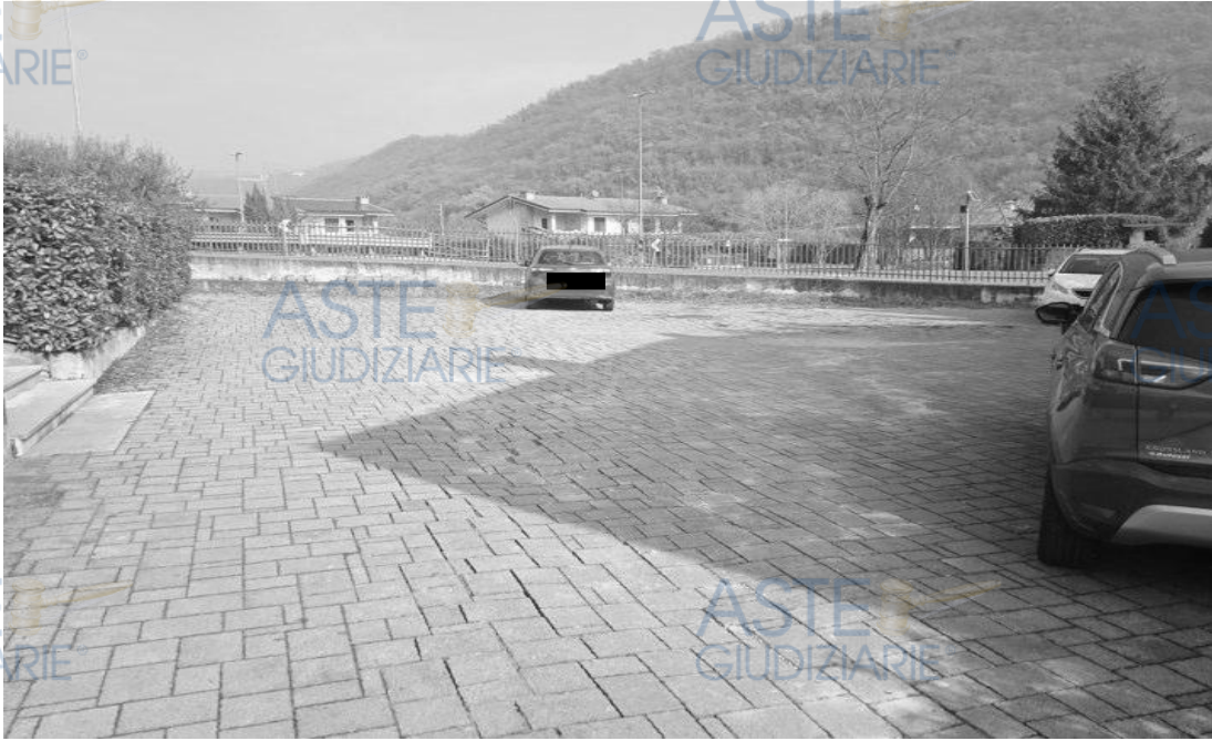
viale interno di ingresso al complesso edilizio con il parcheggio comune in fondo
