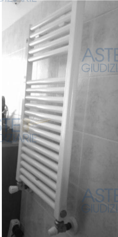
corpi scaldanti tubolari in alluminio nel bagno
