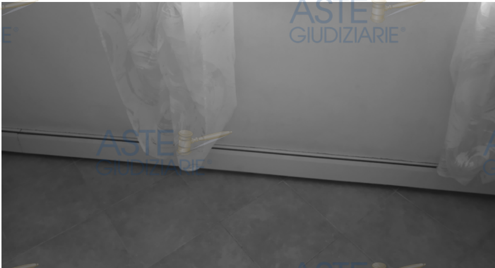
riscaldamento a battiscopa radiante in alluminio
