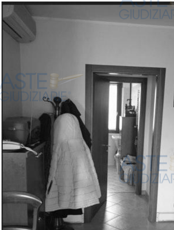
aria condizionata con split a parete nel soggiorno
