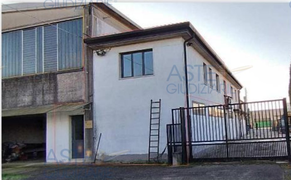
Lato nord esterno palazzina uffici sub 10
