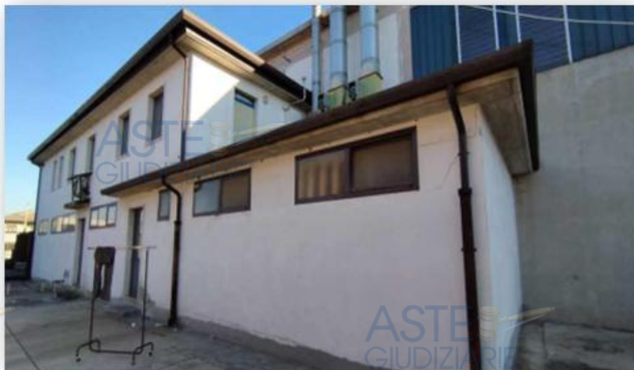
Lato ovest esterno palazzina uffici sub 10
