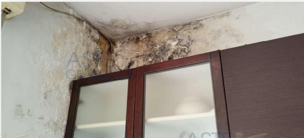
Infiltrazioni soffitto Cucina
