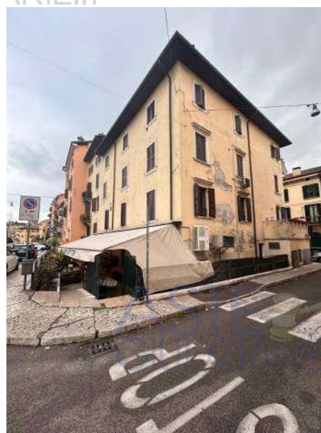
Area esterna di proprietà - lato sud-ovest
