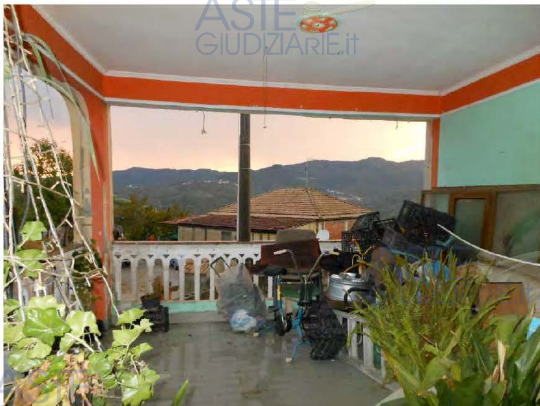
[Foto n°4 – portico]
