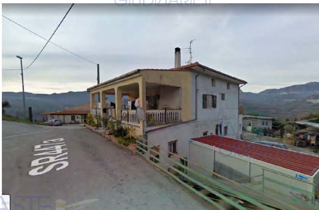
[Foto n°2 – esterno]
