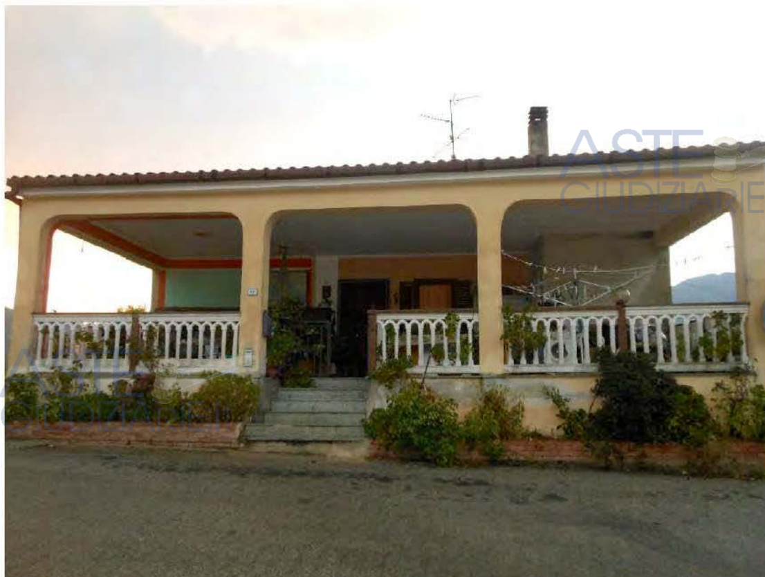
[Foto n°1 – esterno]
