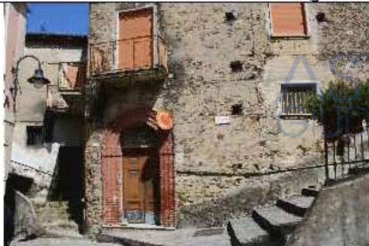
Figura 17- Accesso al fabbricato
