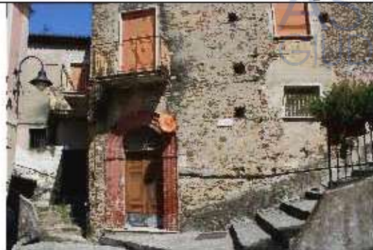
Figura 12 - Accesso al fabbricato
