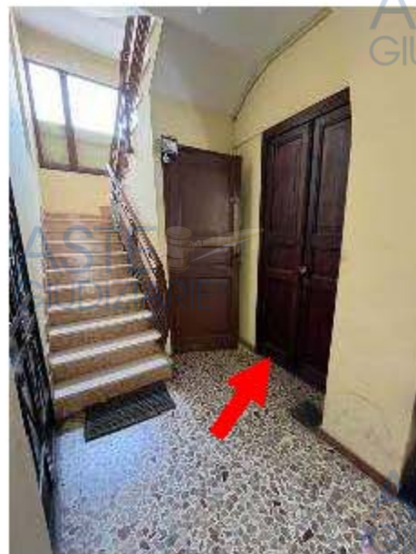
Accesso magazzino da vano scala p.T
