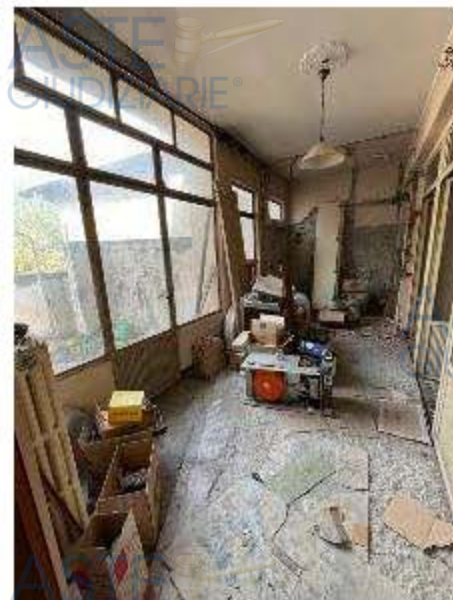
Veranda con servizio igienico demolito
