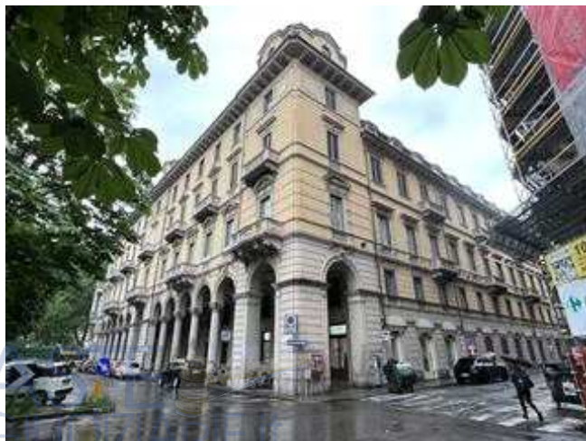
vista del fabbricato sito all'angolo tra il corso Galileo Ferraris e la via San Quintino
