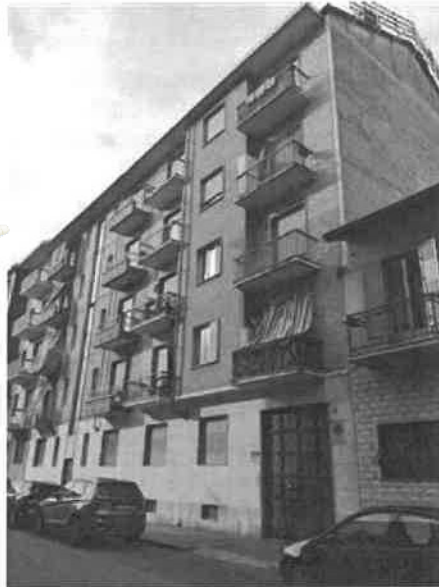
Veduta prospetto est dell'edificio su via Nomaglio, con androne carraiò al n.c.v. 5
