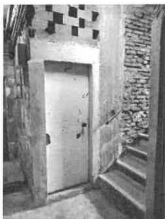
Scale e porta di accesso al locale al piano sotterraneo
