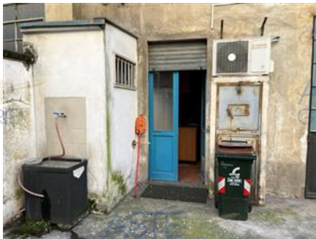
FACCIATA SU CORTILE INTERNO
