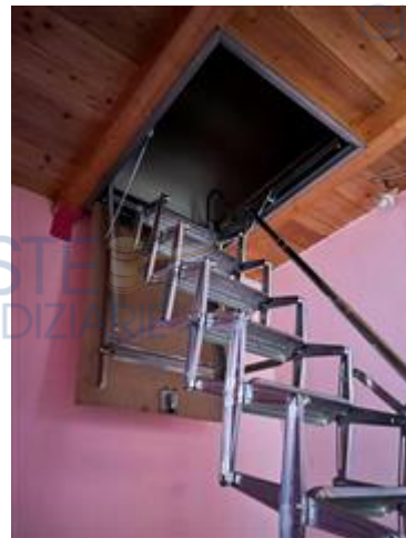
DETTAGLIO SCALA ACCESSO SOPPALCO
