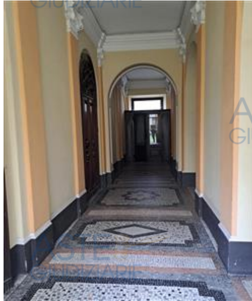
ANDRONE per accesso da Via San Donato
