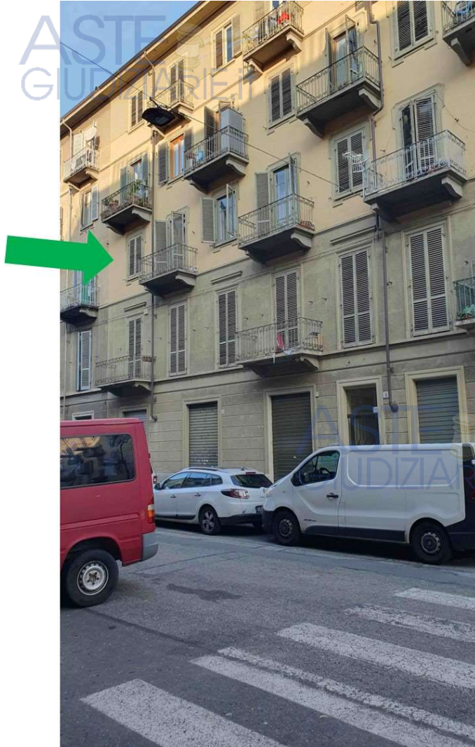
Fig. – facciata stabile sulla via Belmonte
