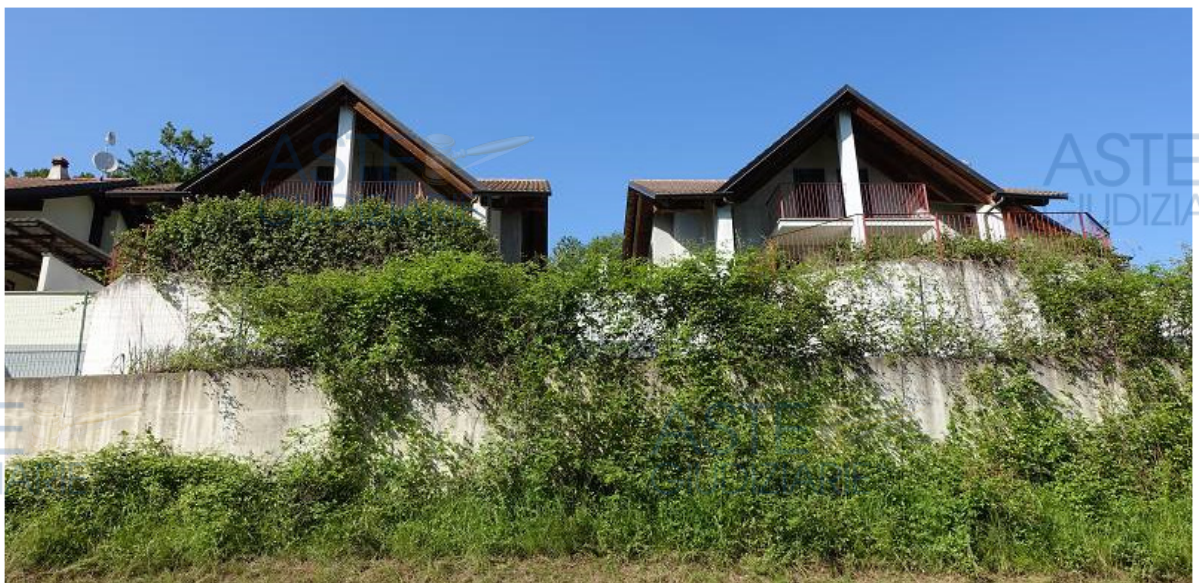
Fig. 5 – Le facciate principali lato strada dei due villini pignorati, a sinistra il sub 4 e a destra il sub 6
