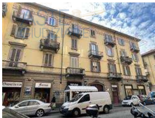
Facciata su via Frejus
