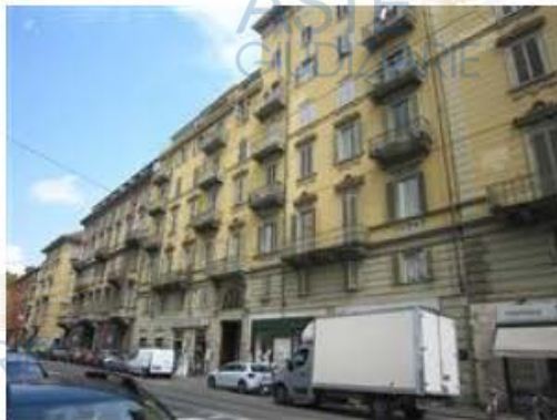
Facciata su Via Madama Cristina
