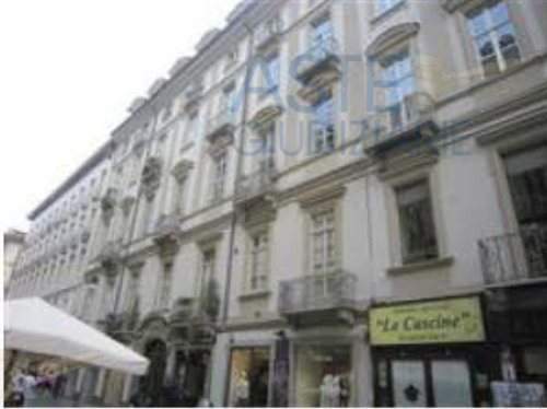
Facciata su Via Garibaldi
