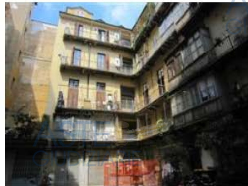
Facciata su cortile interno
