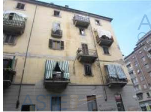
Facciata su Via Bra
