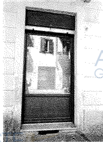
Infissi esterni ex locali 5 e 5bis
