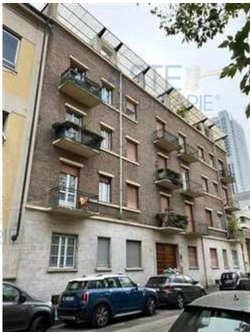
Vista della facciata su via Beaumont
