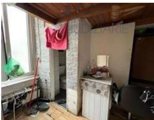
Interno dell'u.i. verso il cortile interno in cui si apprezzano la finestra e la porta del bagno
