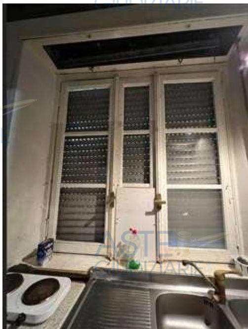
Vista della finestra su via Beaumont
