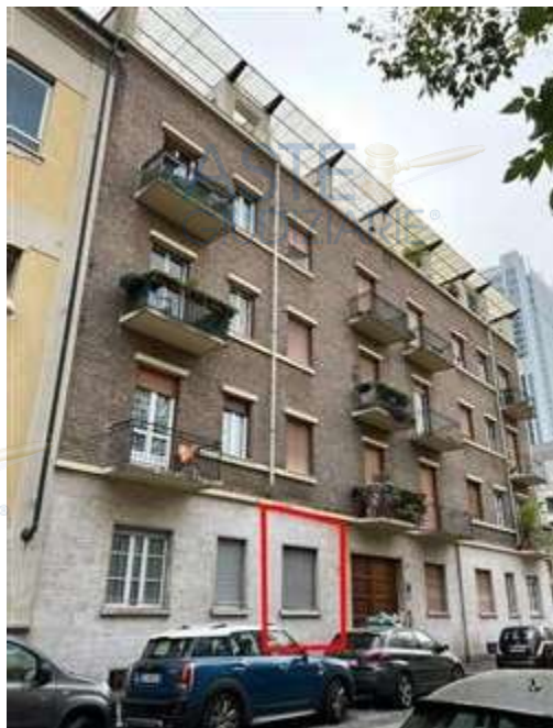
Vista della facciata su via Beaumont in cui la poligonale rossa individua, qualitativamente, l'unità immobiliare di interesse
