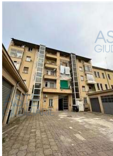
Vista della facciata su cortile interno
