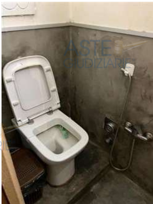
Dettaglio interno del wc
