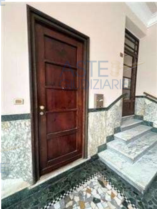
Vista del portoncino di ingresso all'u.i.
