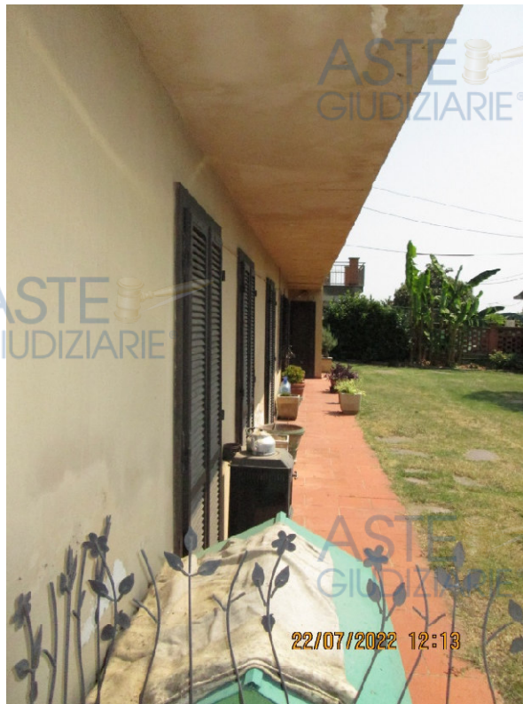
Fronte sud piano terra
