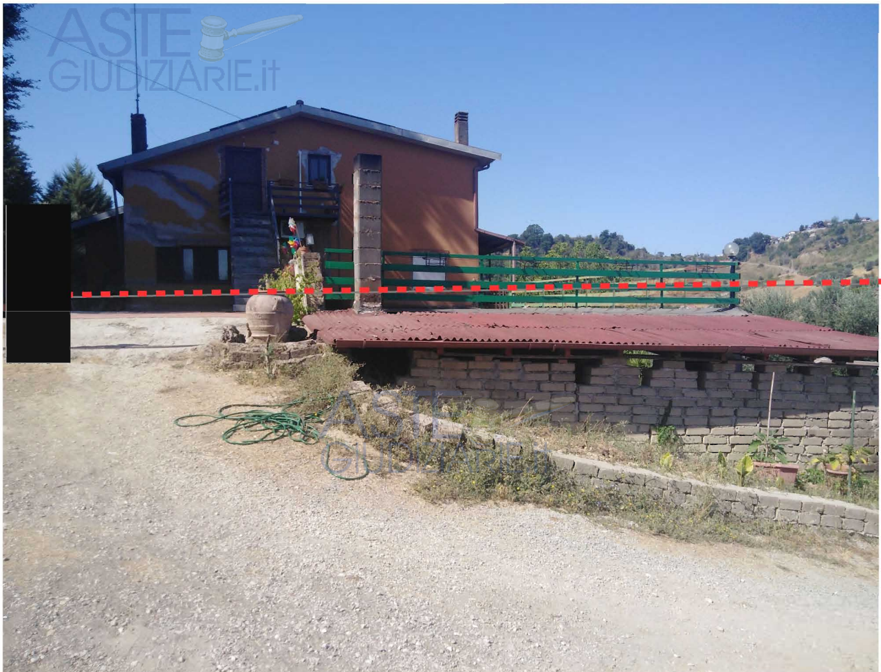
Vista del villino dalla particella 263 non oggetto di esecuzione
